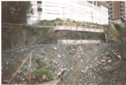
Pantalla doble de micropilotes arriostrada con doble viga anclada bajo vía de ferrocarril
