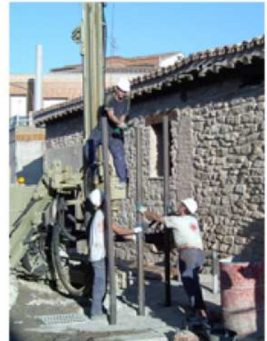
Pantalla de micropilotes para protección en trabajo subterráneo y recalce
