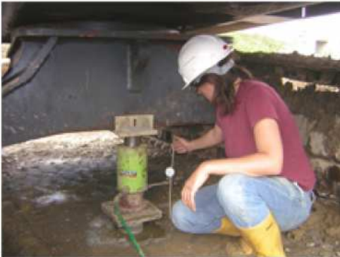
Prueba de carga en micropilote para cimentación
