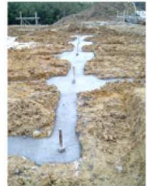
Cimentación sobre micropilotes, hormigón de limpieza.
