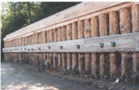
Pantalla de pilotes Ø 800 arriostrada. Ferrocarril Madrid-Irun
